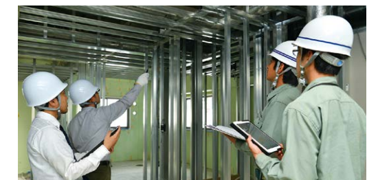
工事段階での品質管理 (イメージ)
