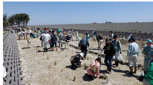
海岸防災林植栽の様子
