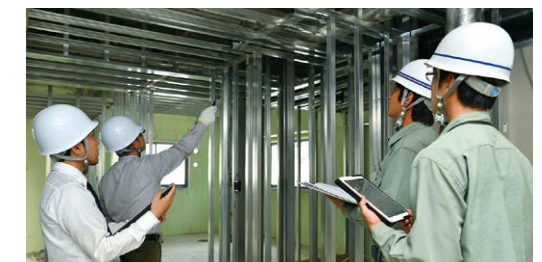
工事段階での品質管理 (イメージ)
